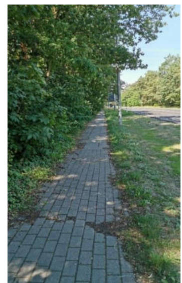
Bild 3-Platten-/Pflasterbefestigung
