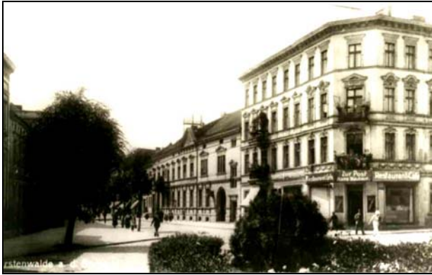
Historische Fassade Eisenbahnstr. 141
